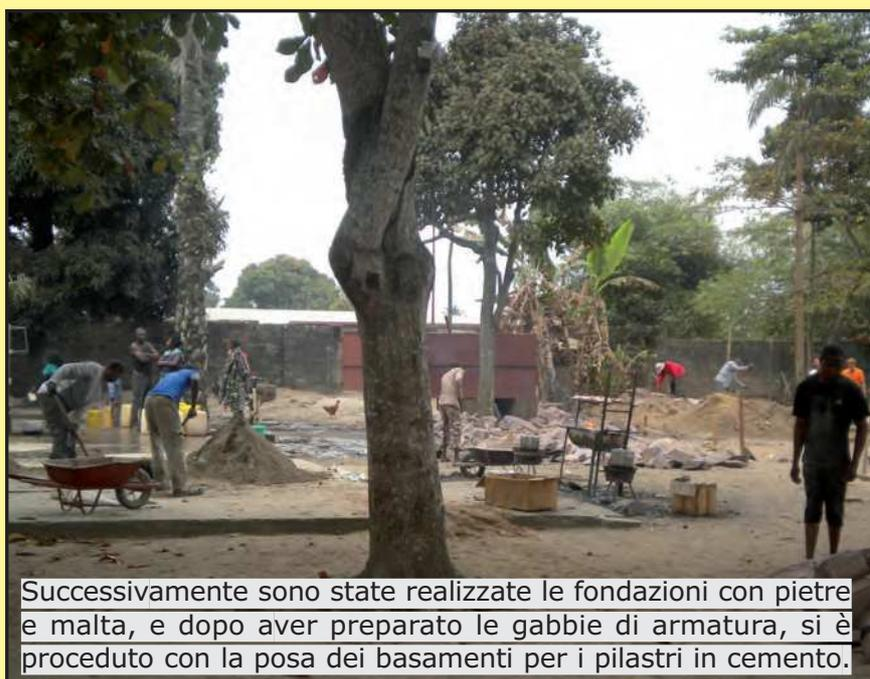
Successivamente sono state realizzate le fondazioni con pietre e malta, e dopo aver preparato le gabbie di armatura, si è proceduto con la posa dei basamenti per i pilastri in cemento.
