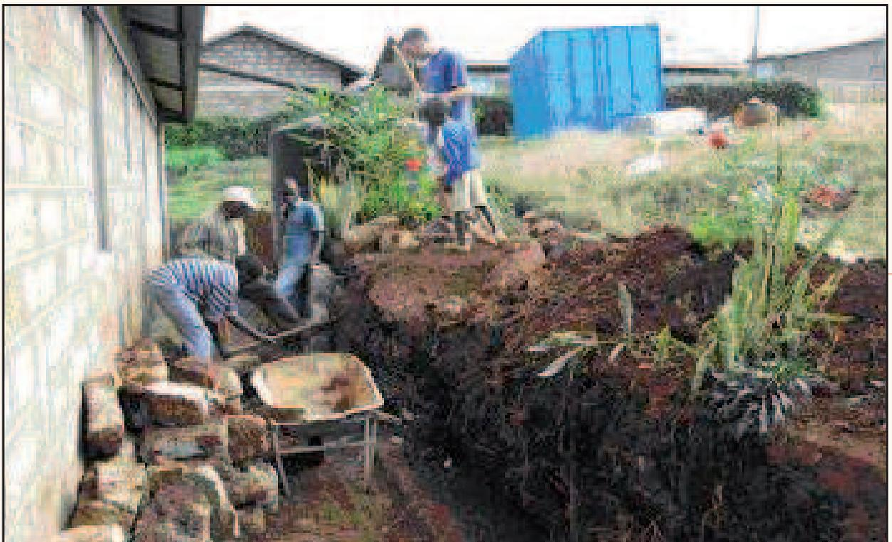
*I lavori di rifacimento del muro di contenimento danneggiato*
