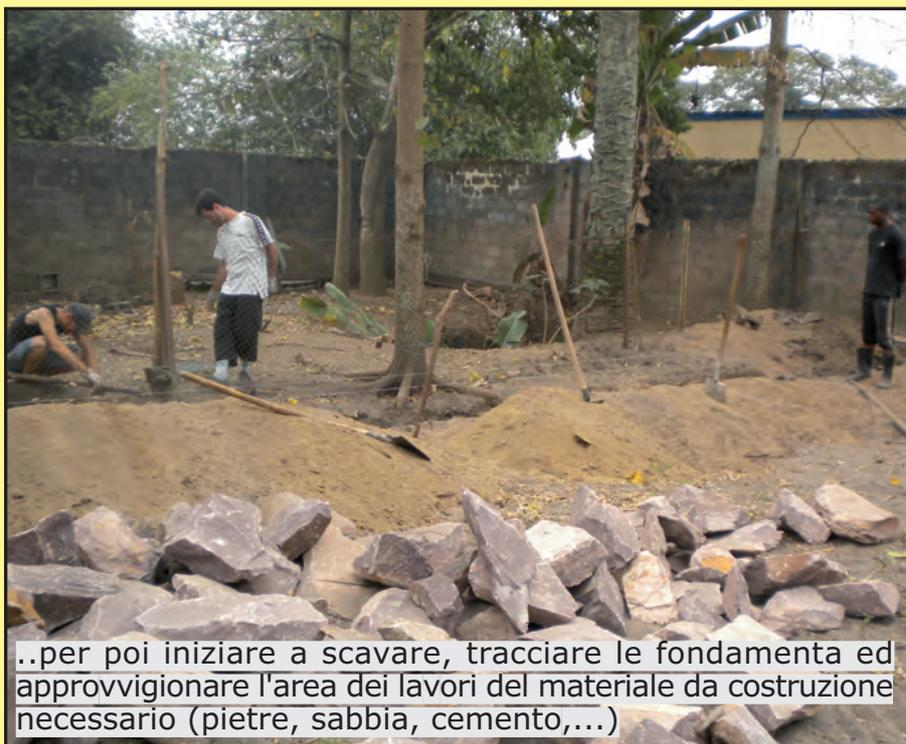
..per poi iniziare a scavare, tracciare le fondamenta ed approvvigionare l'area dei lavori del materiale da costruzione necessario (pietre, sabbia, cemento,...)
