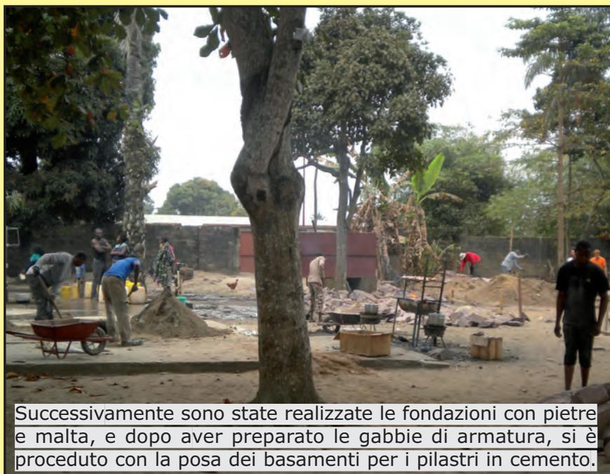
Successivamente sono state realizzate le fondamenta con pietre e malta, e dopo aver preparato le gabbie di armatura, si è proceduto con la posa dei basamenti per i pilastri in cemento.
