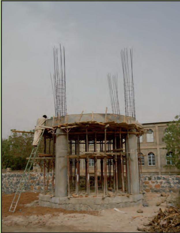
La torre ha una capacità di circa 2.500 litri ed è una costruzione in cemento armato. Questo impianto è stato eseguito a ridosso della costruzione della scuola di Arti e Mestieri, ormai completamente finita, che potrà usufruire quindi di questa struttura. Per quelli che conoscono l'attuale realtà politica e sociale dell'Eritrea e, soprattutto per noi del gruppo GMCC, si tratta di una bella scommessa vinta e che ci procura una grande soddisfazione.
