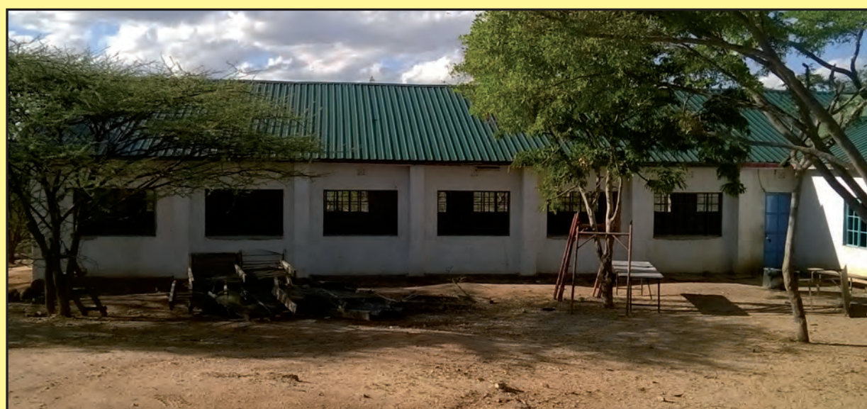
Il refettorio a lavori ultimati
