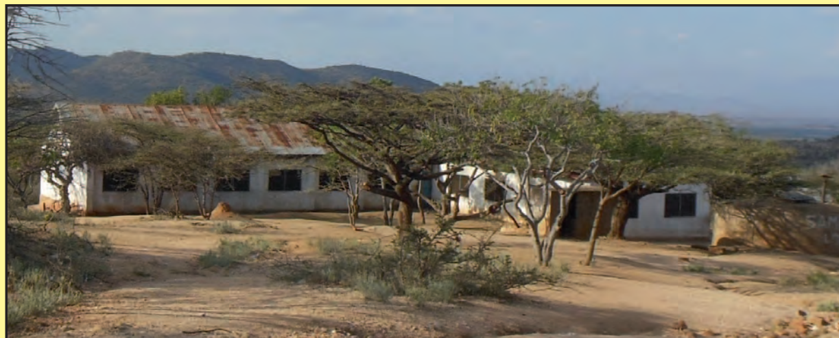
Refettorio e cucina prima dell'inizio dei lavori al tetto.
