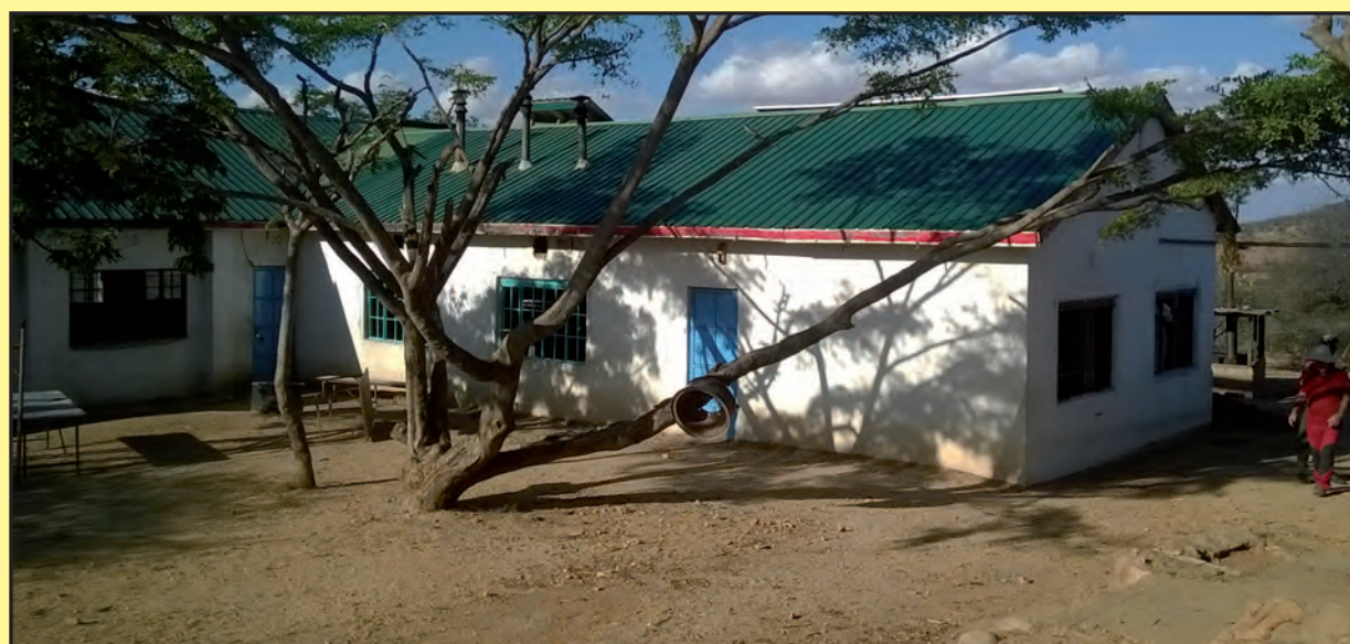
La cucina a lavori ultimati
