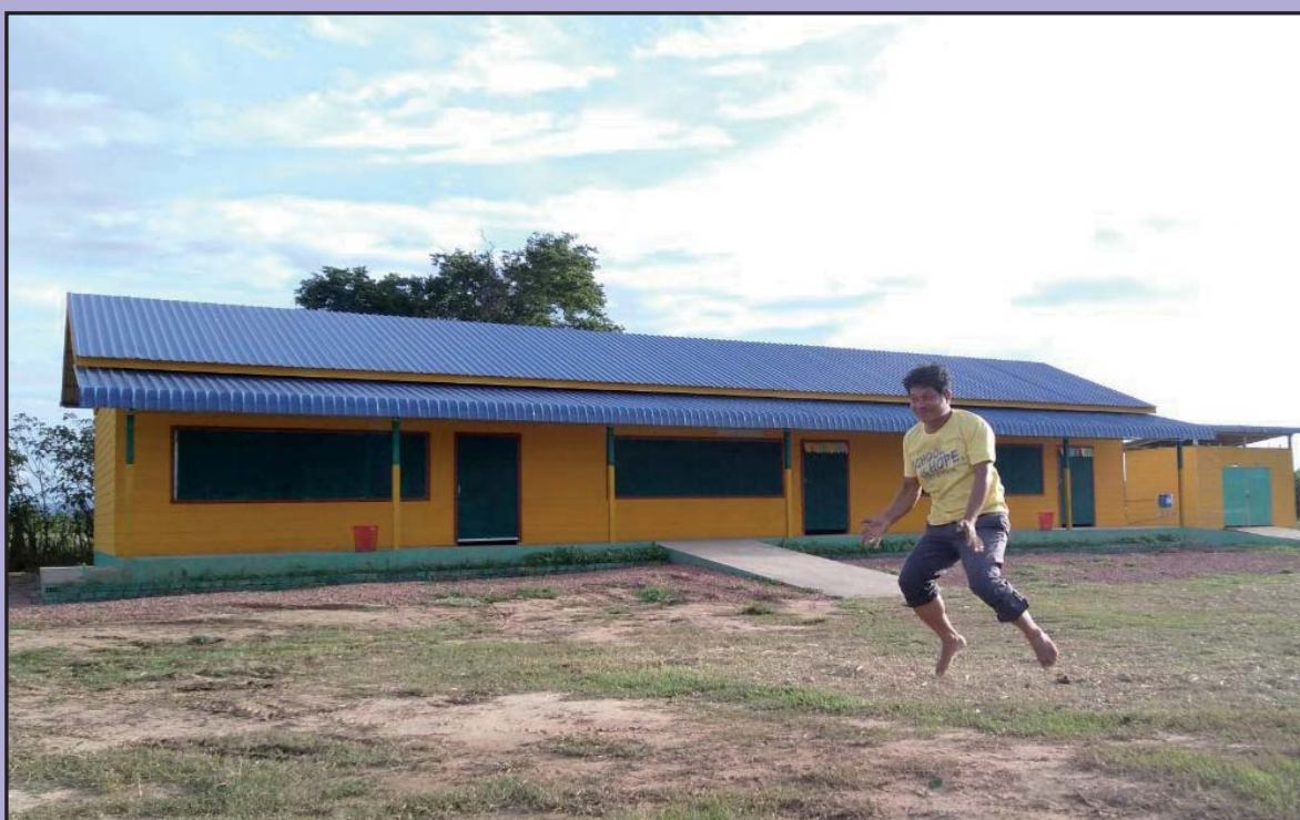
Mr. Khen Bunlee Responsabile del progetto di recupero strutture scolastiche, mostra entusiasta uno degli edifici ristrutturati.
