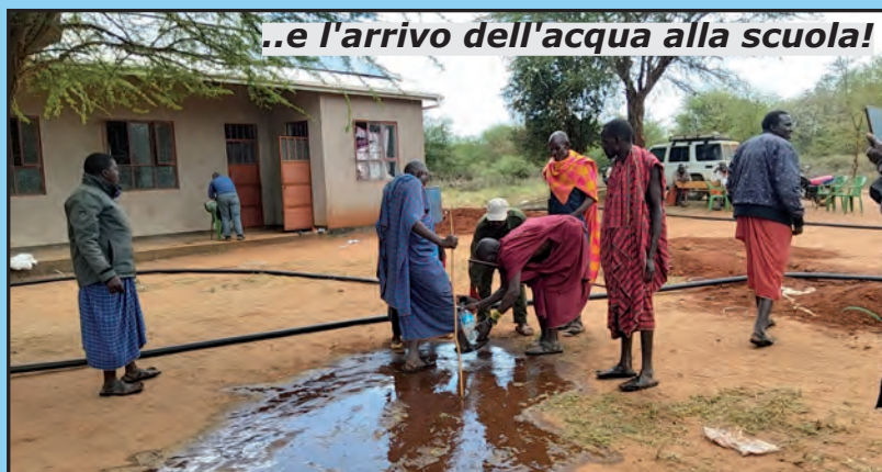
..la posa delle condutture...
